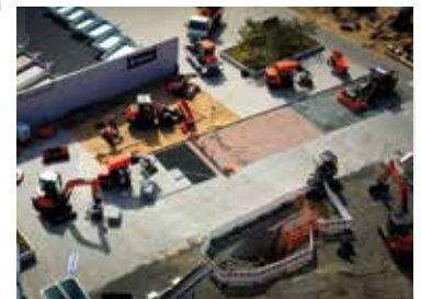
Optimas Musterbaustelle Süd im Coreum, Stockstadt a. R.
